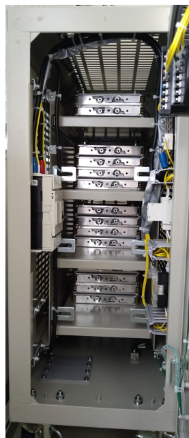
蓄電装置 (リチウムイオン電池) 110V-7.5kWh
